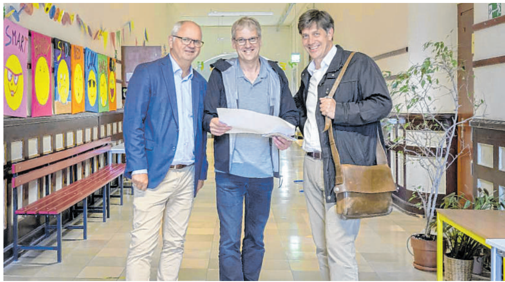
Baustellenbesuch in der Marie-Marcks-Schule: Erster Bürgermeister Jürgen Odszuck (r.), Harald Heußer (l.), Leiter des Hochbauamts, und Thomas Kühner, ebenfalls vom Hochbauamt, begutachten den Schulflur, der eine Schallschutzdecke erhalten und künftig verstärkt im Zuge des Unterrichts, zum Beispiel bei Gruppenarbeiten, genutzt werden soll.
